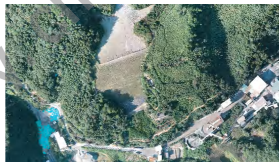
龙岩市小娘坑矿业有限公司矿山设计、 尾矿库设计、安全评价、尾矿库在线监测
